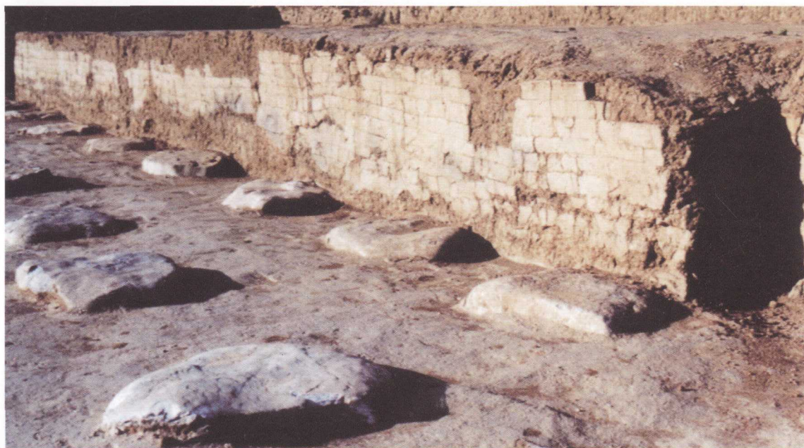
2. 仓储建筑的西夯土墙(东→西)
