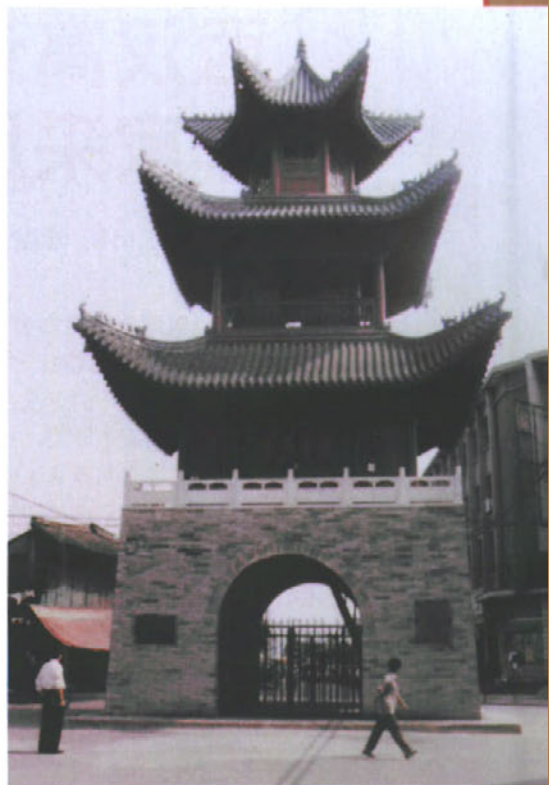
修复后的城固钟楼
